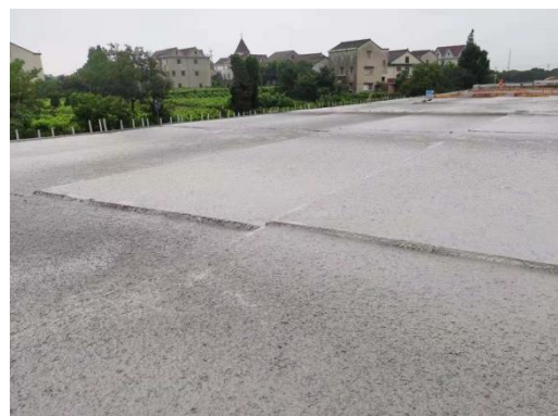
泡沫混凝土成品
