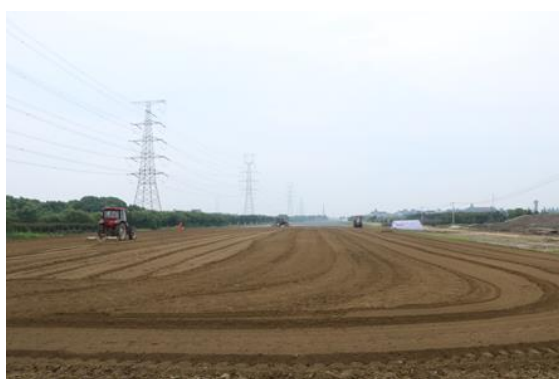
灰土施工过程
