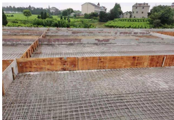
泡沫混凝土施工过程
